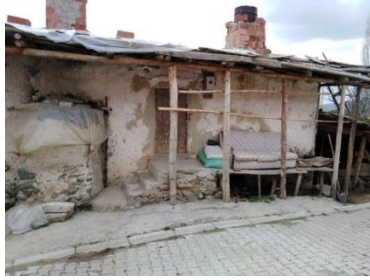
Asbestli tarla toprağı ve asbest kullanılmış bir evin sıvası ve badanası. Sıva ve badanasında asbest kullanılmış bir ev.
